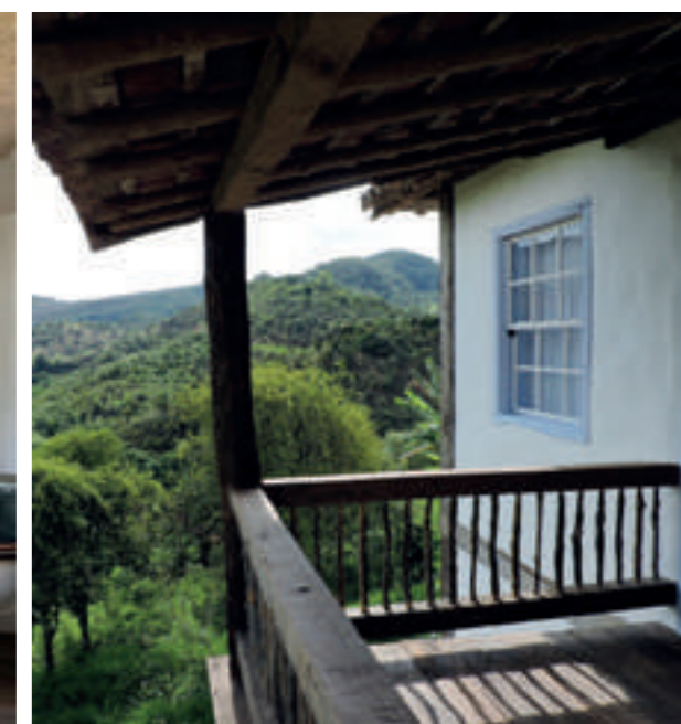
Detalhes do estilo arquitetônico sustentável: ventilação natural, forro de palha, reutilização de telhas e de madeira
